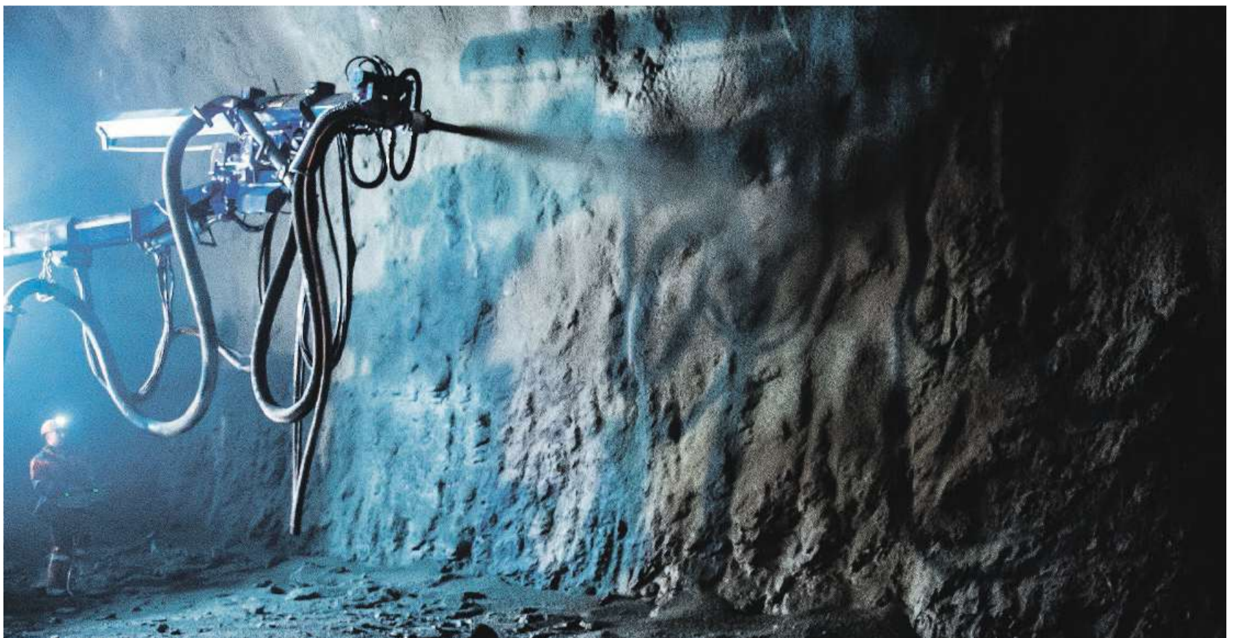
Teurer Infrastrukturbau: Arbeiten am Tunnel Visp für die Realisierung der A9. Foto: Olivier Maire (Keystone)
